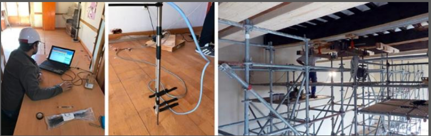
Técnicas de inspección aplicadas al mantenimiento del patrimonio
